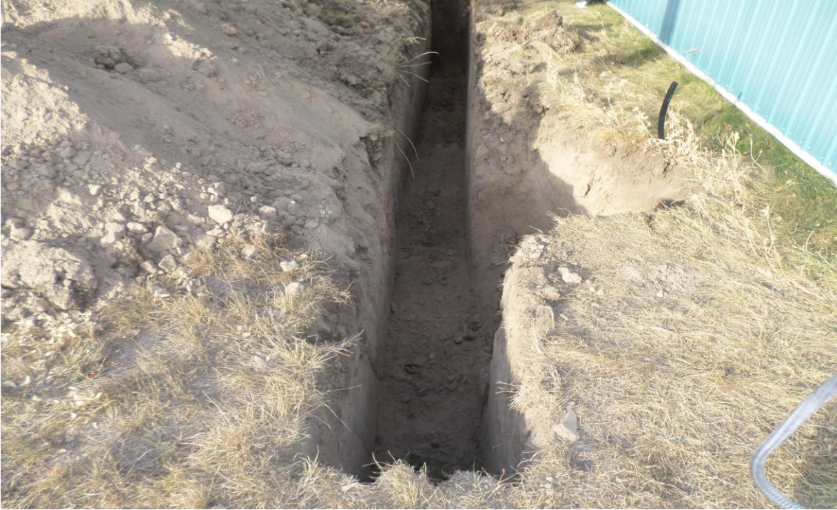
Milli Horn Cloud Gemeindehaus Aushub November 2016
